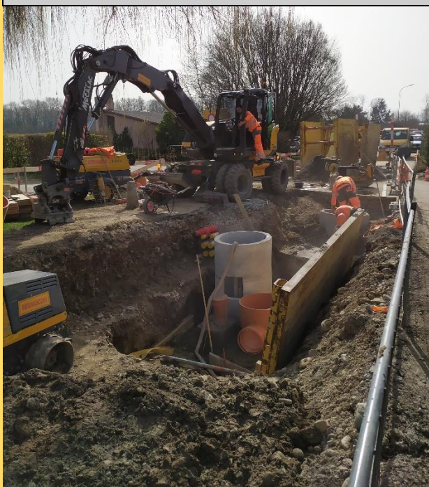
Route de l'Eaumorte Construction des canalisations eaux claires et eaux usées
