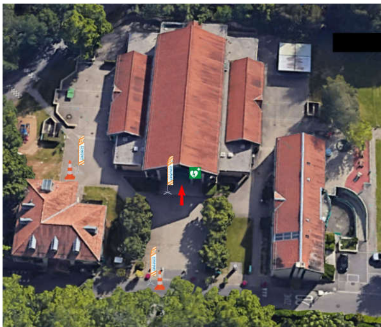
Salle communale Chemin de Sous le Clos 32
